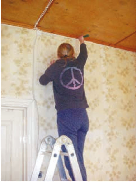
Heidi Hyttinen irrottaa sähköjohtoja.
